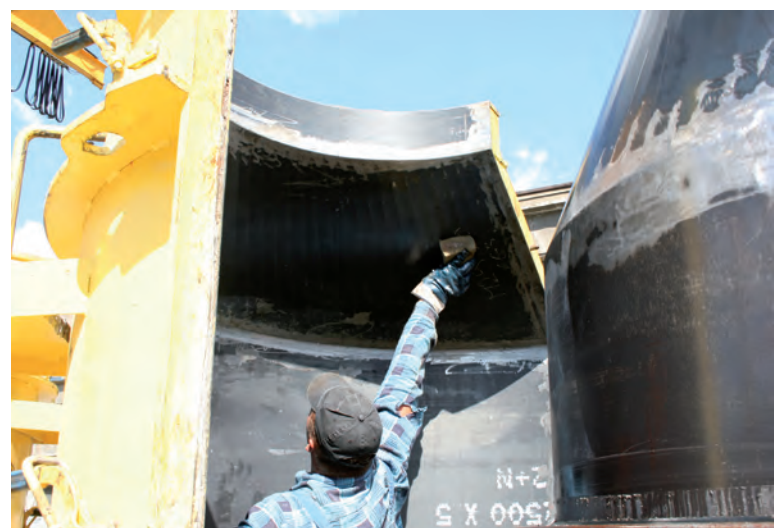
Обработка внутренних поверхностей формы разделительной смазкой Ortolan SEP 791 от MC Bauchemie
