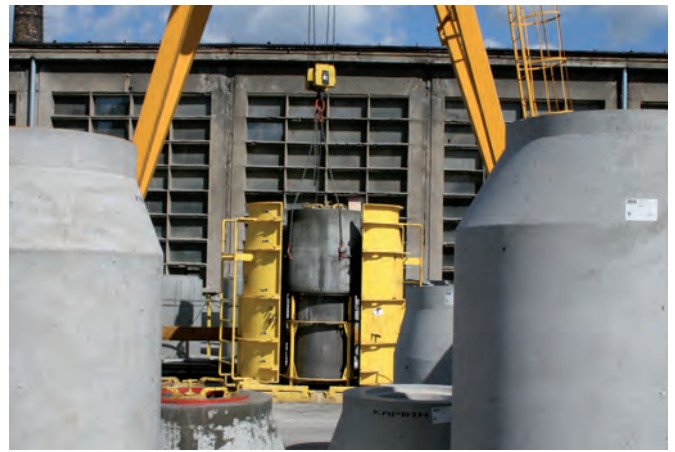
Бетонирование с помощью вилочного автопогрузчика и бадьи для; как и для системы Perfect обычно используется самоуплотняющийся бетон
