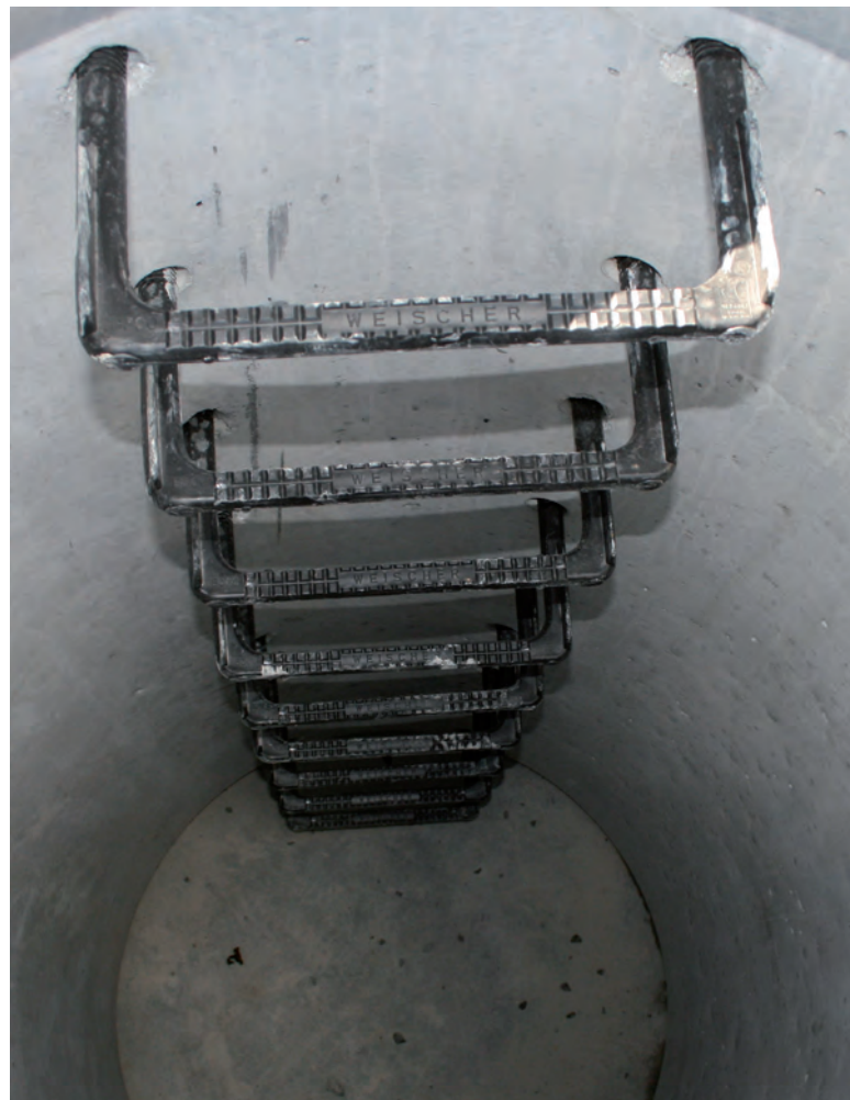
Скобы устанавливаются после распалубки
